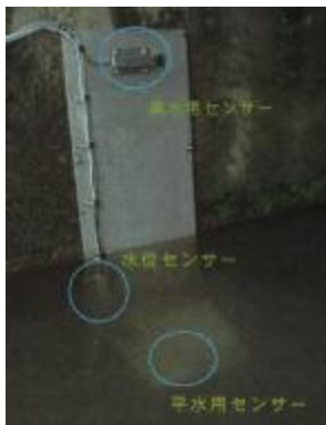
小規模河川出水時の流速観測で設置
