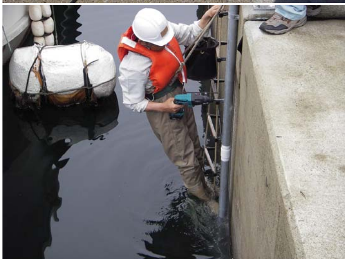
潮位計センサー保護管設置状況 (アンカーボルトで固定する)
