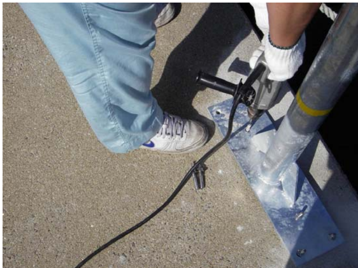
収納ケース設置状況 (アンカーボルトで固定する)
