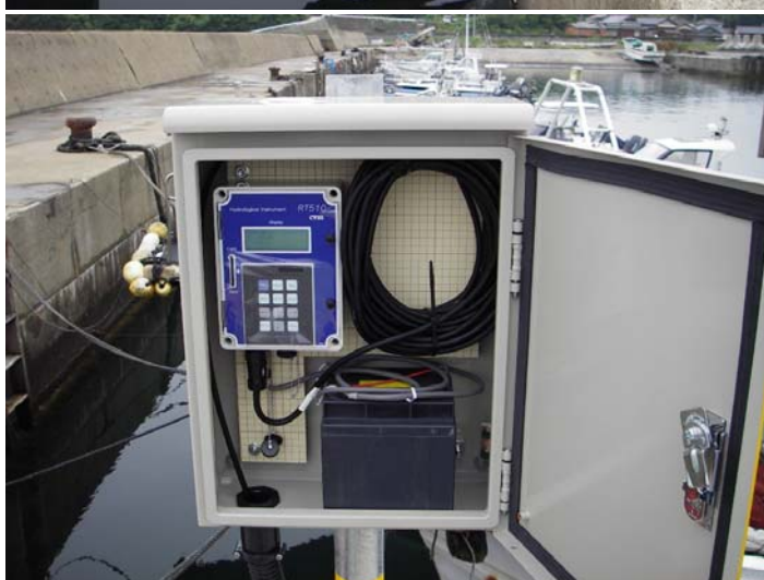
潮位計設置状況 (潮位計センサーを保護管内に挿入後、ロガーを収納ケース内にボルトで固定する)
